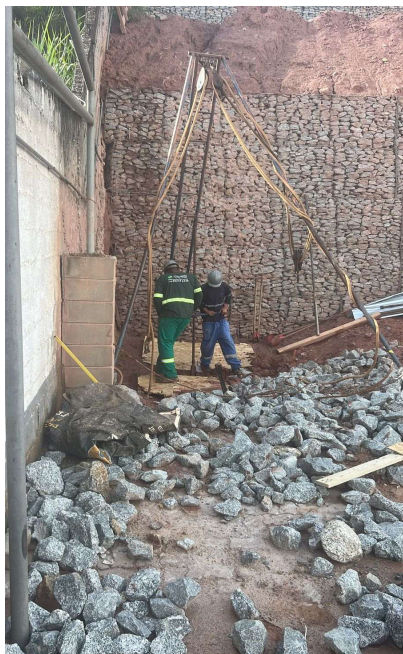
FOTO 09: PERFURAÇÃO DE SOLO
