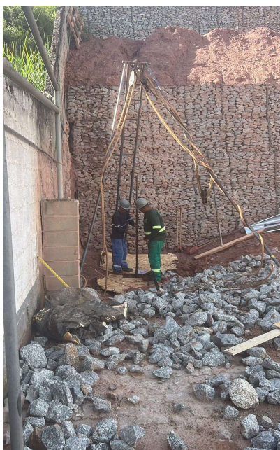
FOTO 07: PERFURAÇÃO DE SOLO
