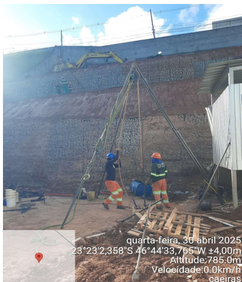
FOTO 11: PERFURAÇÃO DE SOLO
