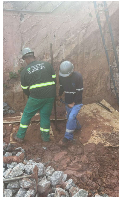
FOTO 10: PERFURAÇÃO DE SOLO
