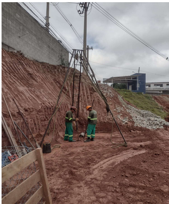
FOTO 04: PERFURAÇÃO DE SOLO
