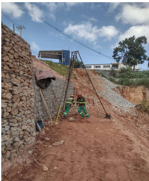
FOTO 05: PERFURAÇÃO DE SOLO
