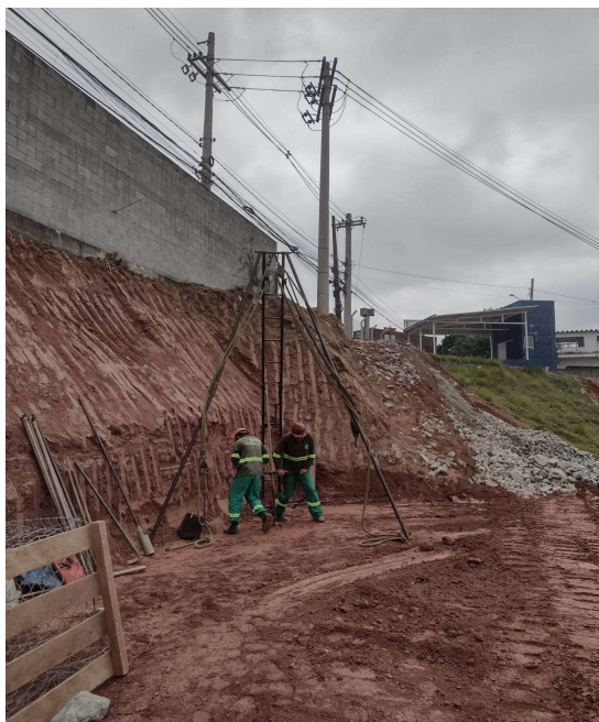
FOTO 03: PERFURAÇÃO DE SOLO
