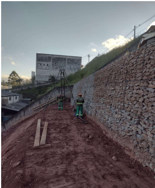
FOTO 01: PERFURAÇÃO DE SOLO
