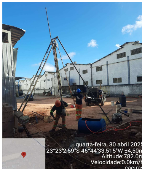
FOTO 12: PERFURAÇÃO DE SOLO
